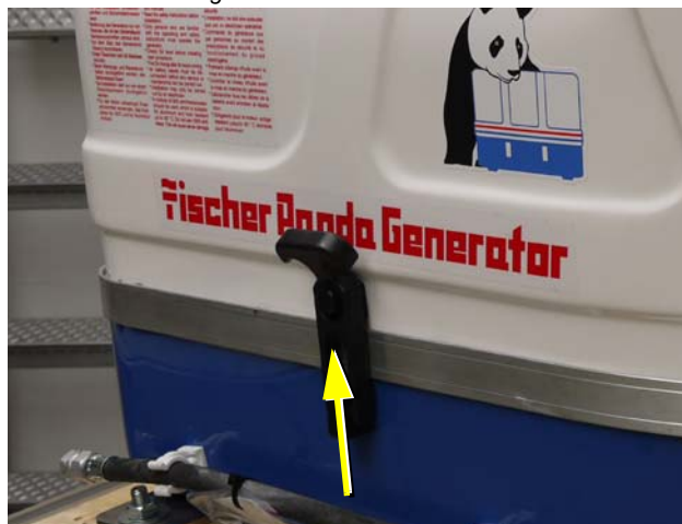
Fig. 3.7-2: Laschenverschlüsse
